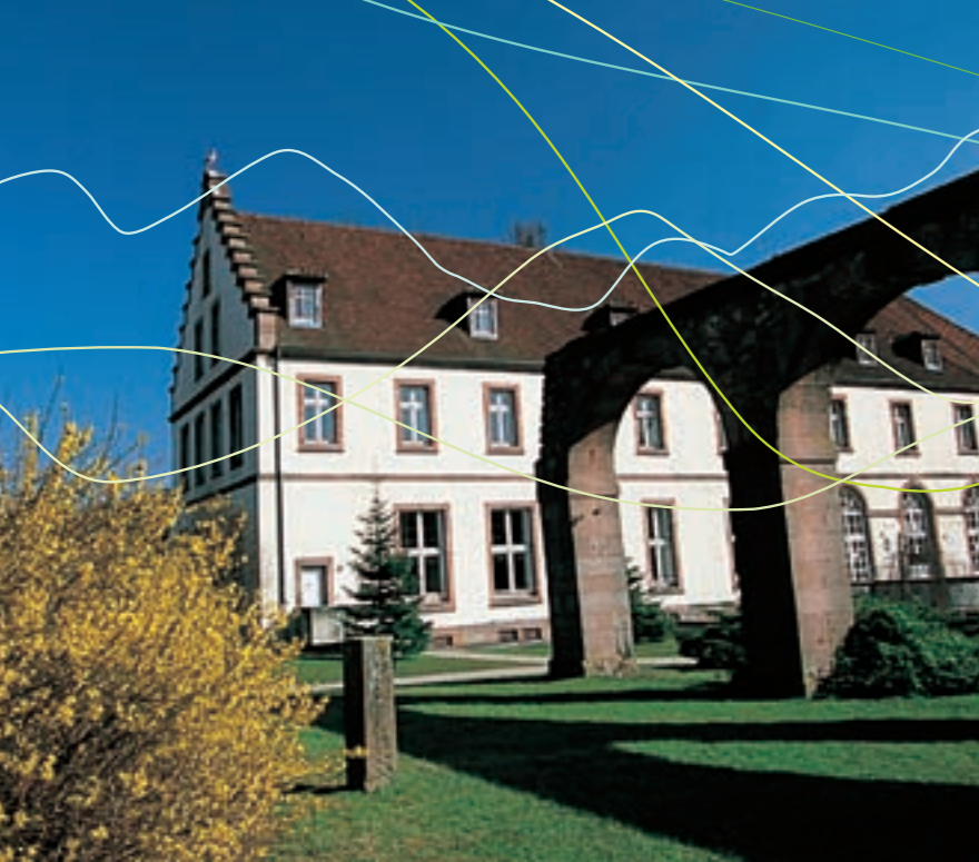
Maison du Parc à Munster
