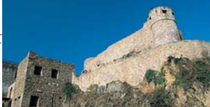
Château du Hohlandsbourg
